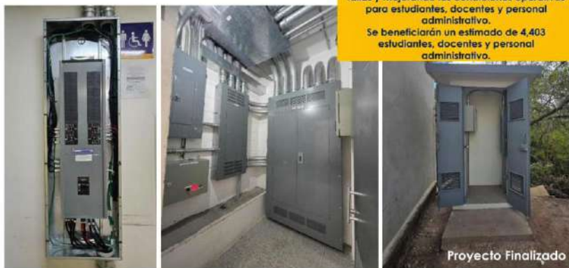
Readecuación y Mejoramiento de Sistema Eléctrico de Distribución y Transformación de Energía en Edificio B2, Ciudad Universitaria
