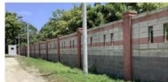
Muro, Iluminación Perimetral y Transformadores
