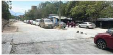
Pavimentación de calle frente a Edificio EUCS
