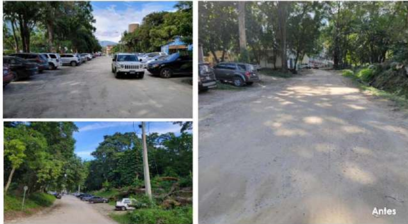
Pavimentación Calles Internas y I Etapa de Tramo Subterráneo de Media Tensión, UNAH Cortés.
