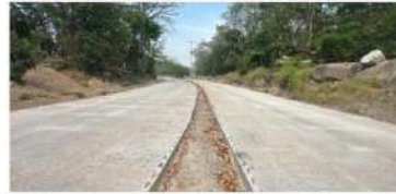
Pavimentación de dos carriles desde estacionamiento Edificio No.1 hacia rotonda frente a Edificio EUCS.
