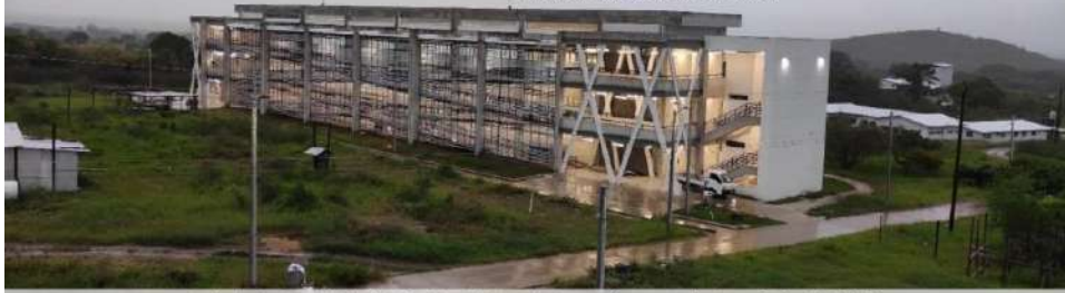
Fachada Norte, Edificio de Aulas No.1, destaca la rampa de acceso a los tres niveles del Edificio
