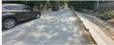
Pavimentación de calle doble vía y enchape de canal abierto en calle ubicada en perímetro Norte del Campus.
