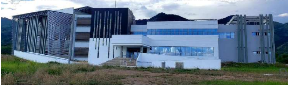
Fachada Sur, Edificio Administrativo. Se destaca el acceso principal al Edificio
