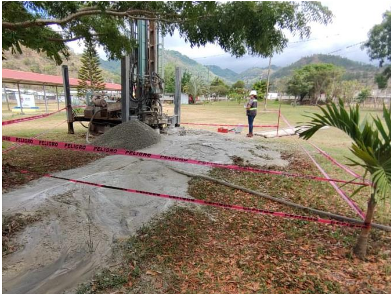
Construcción de un pozo para la extracción de agua subterránea de 10" de diámetro terminado y 200 pies (60 m) de profundidad. Población Beneficiaria: 926 estudiantes
