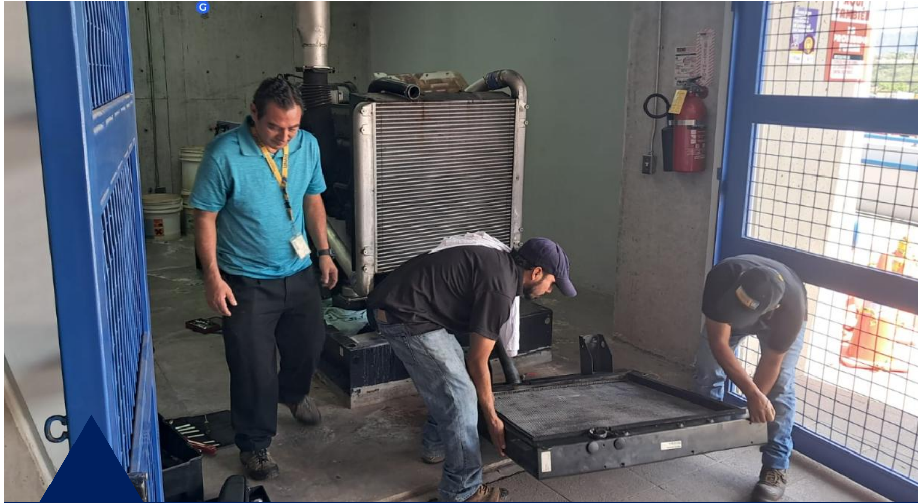
Cambio de radiador Generador Polideportivo.
