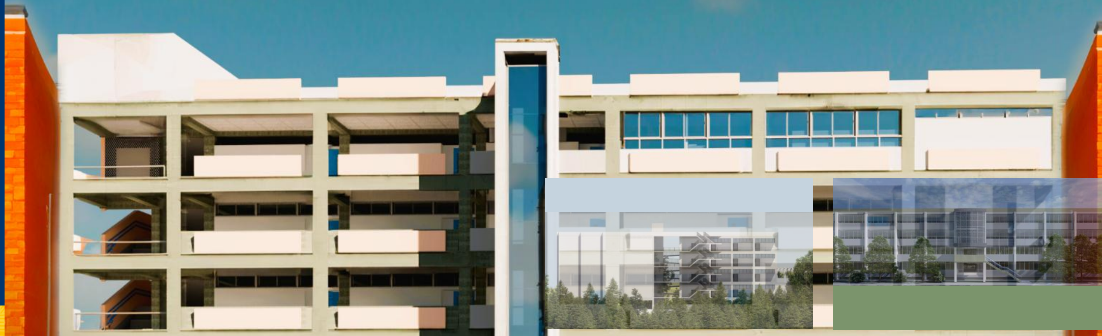
Mejoramiento y Construcción Anexo Edificio J1, Ciencias Biológicas, Facultad de Ciencias Ciudad Universitaria.
