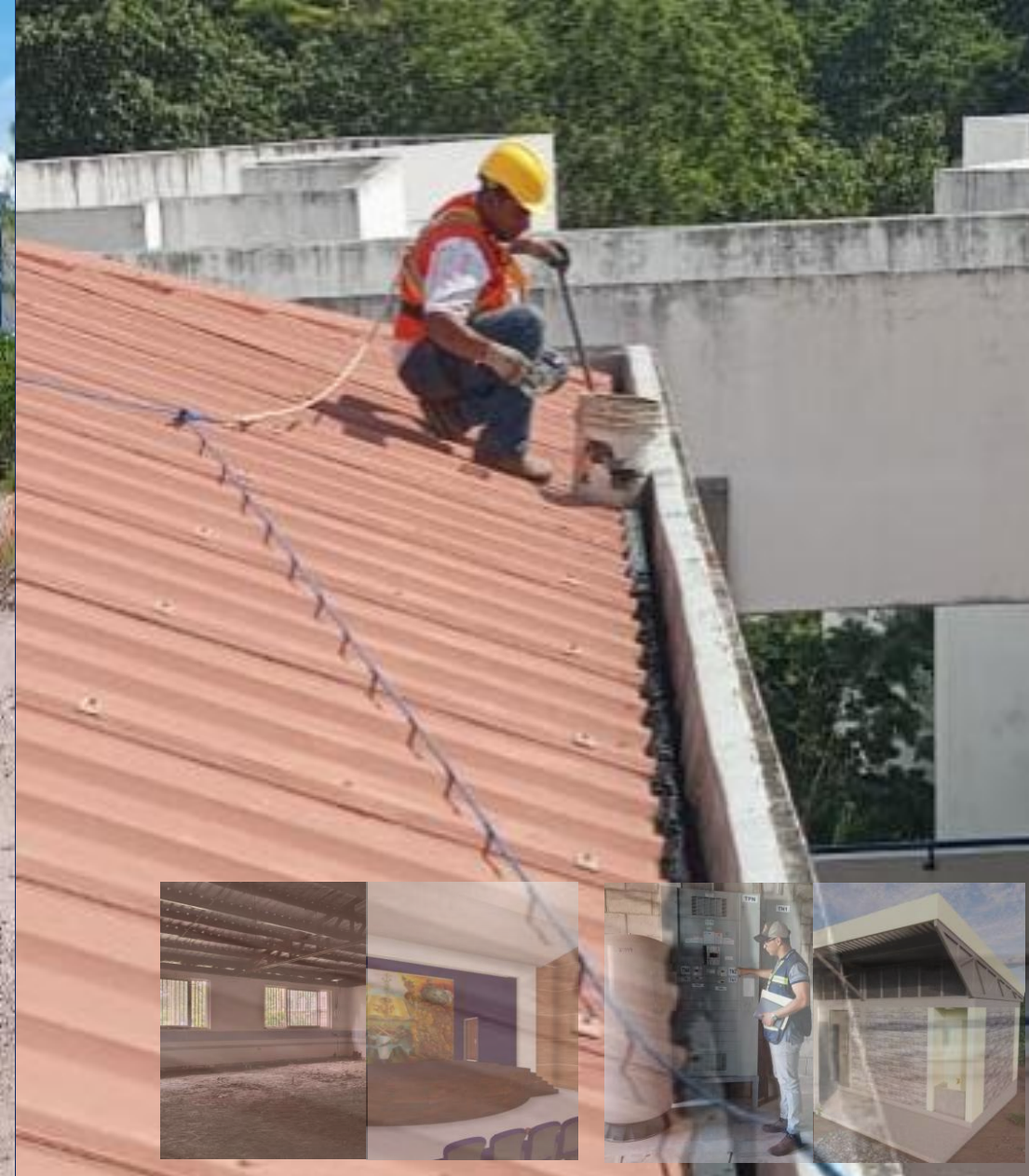
Impermeabilización Losas Azotea, Reparación Techos en Edificios y Obras Complementarias Civiles y Electromecánicas, UNAH Campus Cortés
