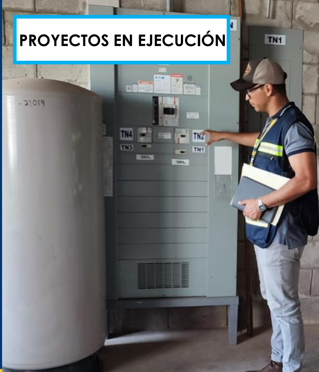
Mejoramiento y Readecuación Sistema Eléctrico, UNAH Campus Yoro
